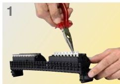
1 Retrait du peigne sur le bornier phase/neutre
