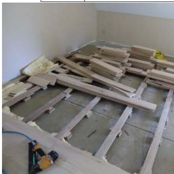
fig. 10.3 la pose sur lambourdes (1)
