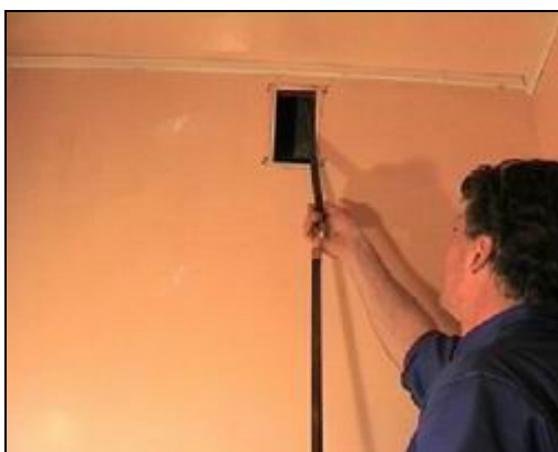
Passage des câbles à l'aide d'une canne de ramonage depuis le logement vers la terrasse.
