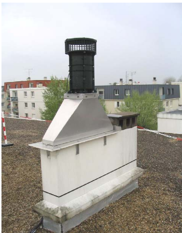
Figure 26: ventilateur VBP sur pièce d'adaptation existante
