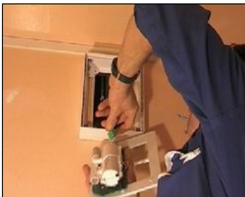
Raccordement et fixation du dispositif de prise mesure dans le logement.
