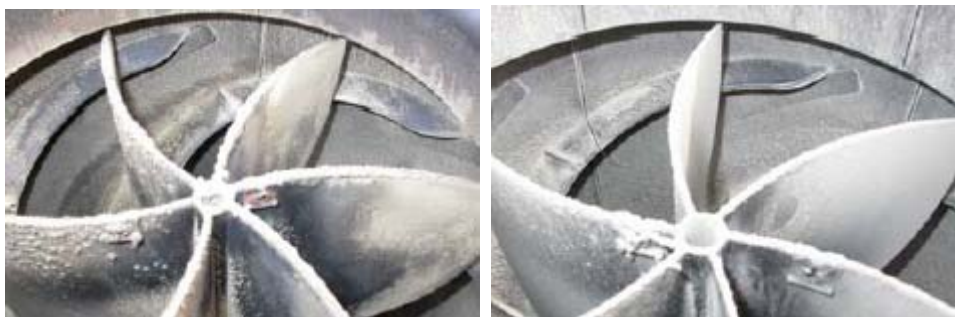
Figure 72 : Encrassement d'un ventilateur VBP après 16 mois d'utilisation sans entretien en cuisine (gauche) et en WC (droite)
