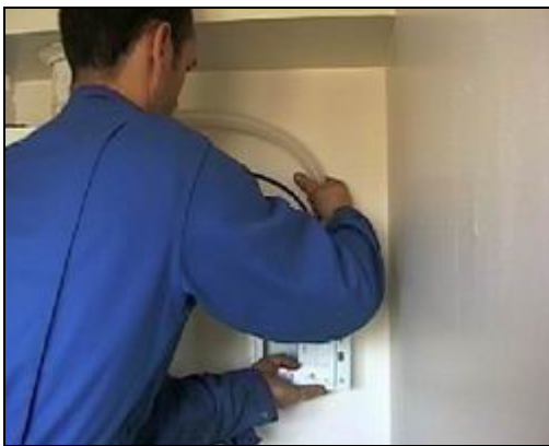
Raccordement du tube de mesure de pression sur conduit de l'appareil à gaz.
