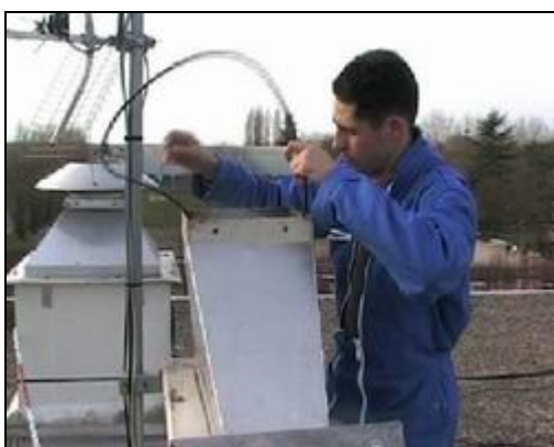
Descente des câbles de connexion dans le conduit.
