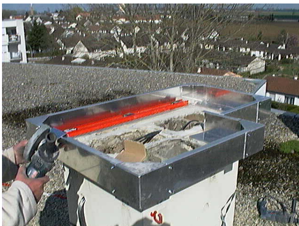
Figure 28: réalisation de pièces d'adaptation spécifiques
