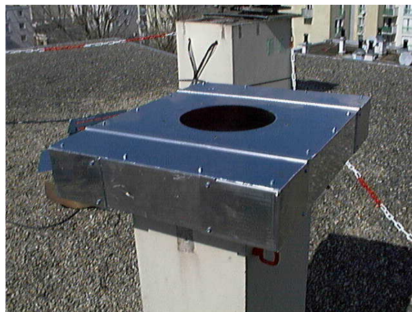
Figure 28: réalisation de pièces d'adaptation spécifiques
