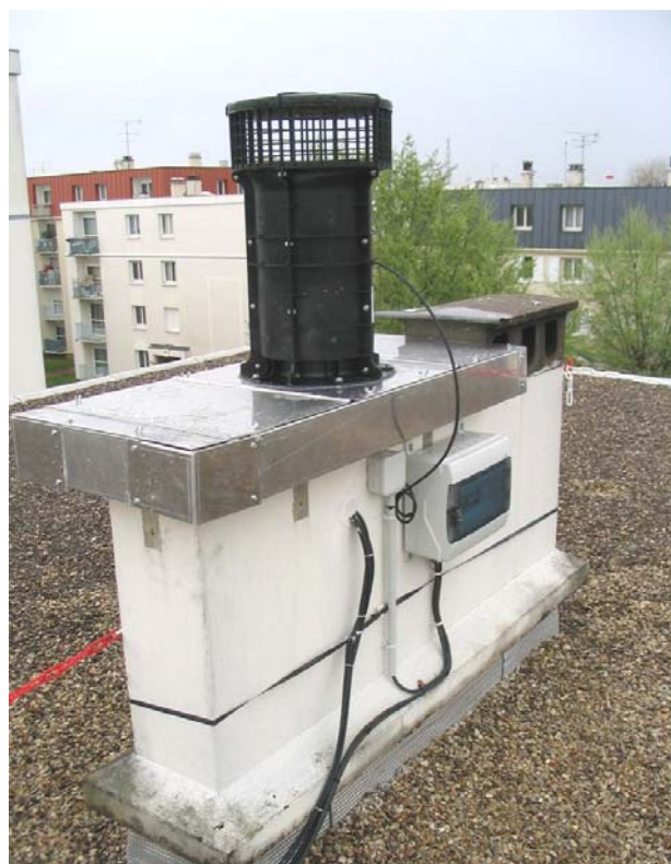
Figure 27: ventilateur VBP sur nouvelle pièce d'adaptation
