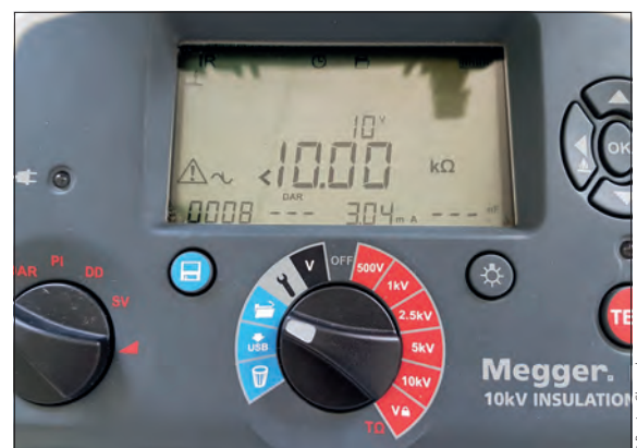
7 Résultat de mesure d'un transformateur en défaut d'isolement
