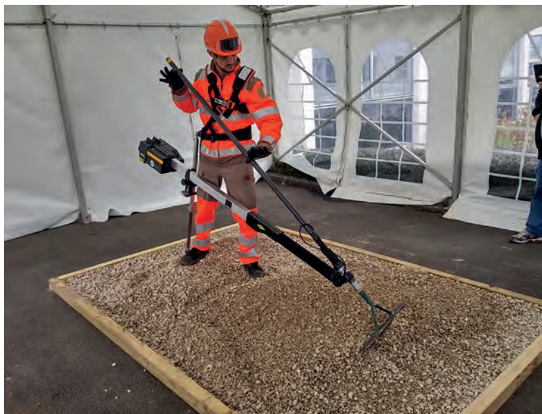
7 Conçu par RB3D et Colas, l'ExoPush aide les ouvriers à étaler le bitume ; la charge de l'outil est reportée vers la taille et les pieds
