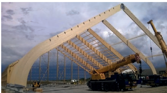
32 Montage par grue d'une structure en lamellé-collé avec une portée de 50 m
