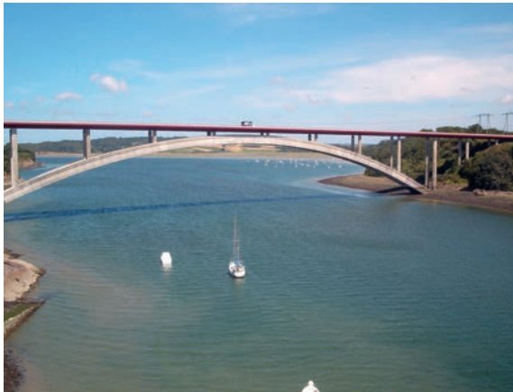
7 Pont Chateaubriand sur la Rance conçu par Charles Lavigne, Ille-et-Vilaine
