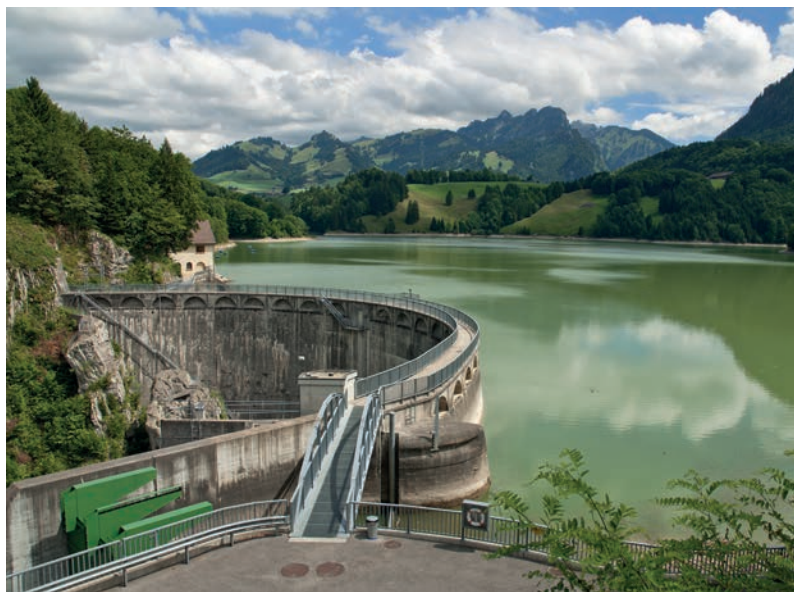
35 Barrage-voûte de mont Montsalvens à proximité de Charmey, Suisse (1920)
