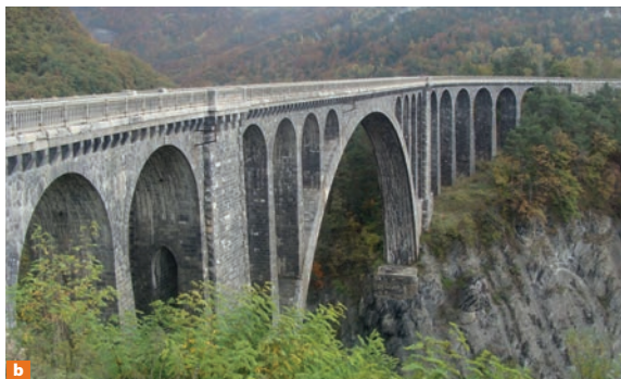
24 Viaduc de la Roizonne dans l'Isère : (a) construction de la grande arche (portée 80 m) à l'aide d'un cintre (été 1916) ; (b) vue générale aujourd'hui
