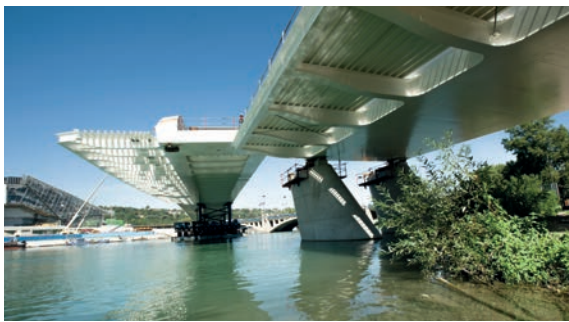
30 Pont Raymond-Barre, Lyon
