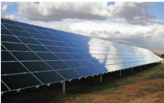
4 La centrale terrestre de Waldelgesheim (Allemagne)
