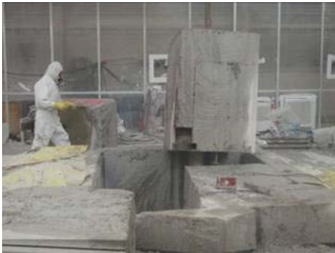
Extraction d'une partie de la sole du réacteur après découpe au câble.
