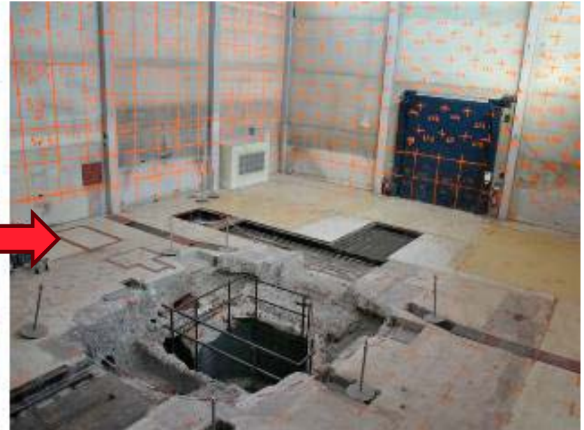
Après démantèlement - Assainissement
