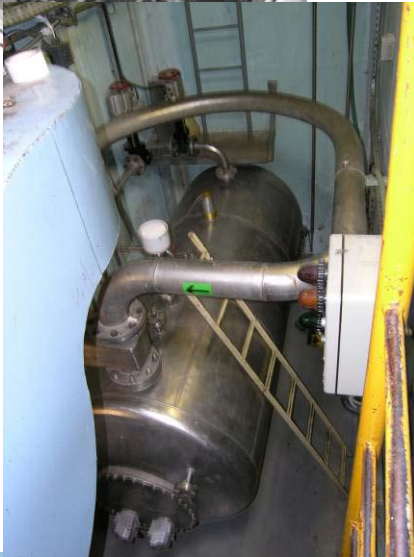
Fosse ouest : bac de désactivation
