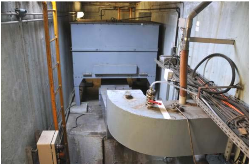
gaine de ventilation provenant du bloc réacteur et entrant dans le filtre très haute efficacité.
