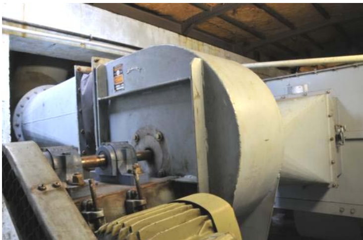
Gaine de ventilation et le ventilateur en aval du filtre très haute efficacité.
