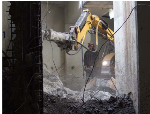
Démolition béton à l'aide d'un brise-roche hydraulique sur porteur Brokk 400.
