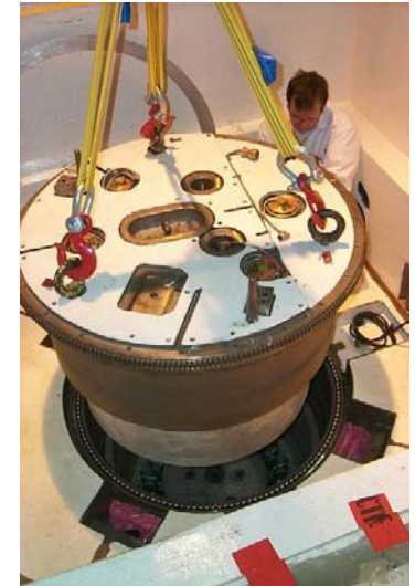
Retrait du bouchon tournant
