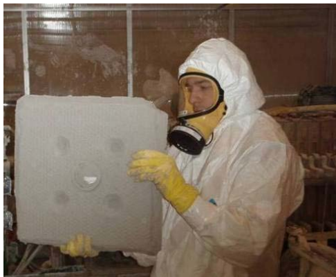
Galette de boue obtenue à l'aide d'un filtre-presse (chantier du réacteur universitaire de Strasbourg).
