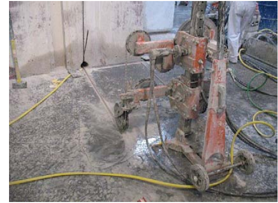
Bâti de sciage au câble diamanté, avec ses poulies de renvoi. Le câble est ici au ras du sol, et disparaît dans un carottage (découpe conventionnelle du bloc du Réacteur universitaire de Strasbourg).
