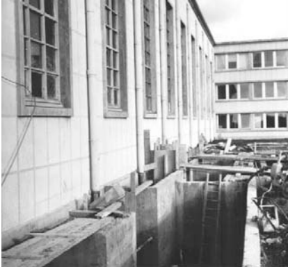
Les fosses, à l'extérieur du bâtiment, lors de la construction.
