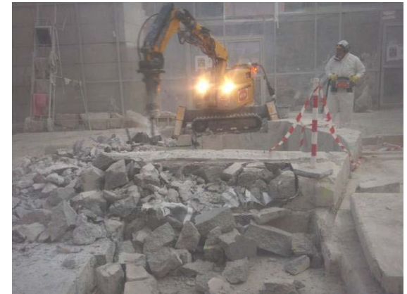
Brise-roche hydraulique sur porteur Brokk utilisé pour achever la démolition de la dalle.
