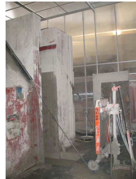
Découpe du massif en béton
