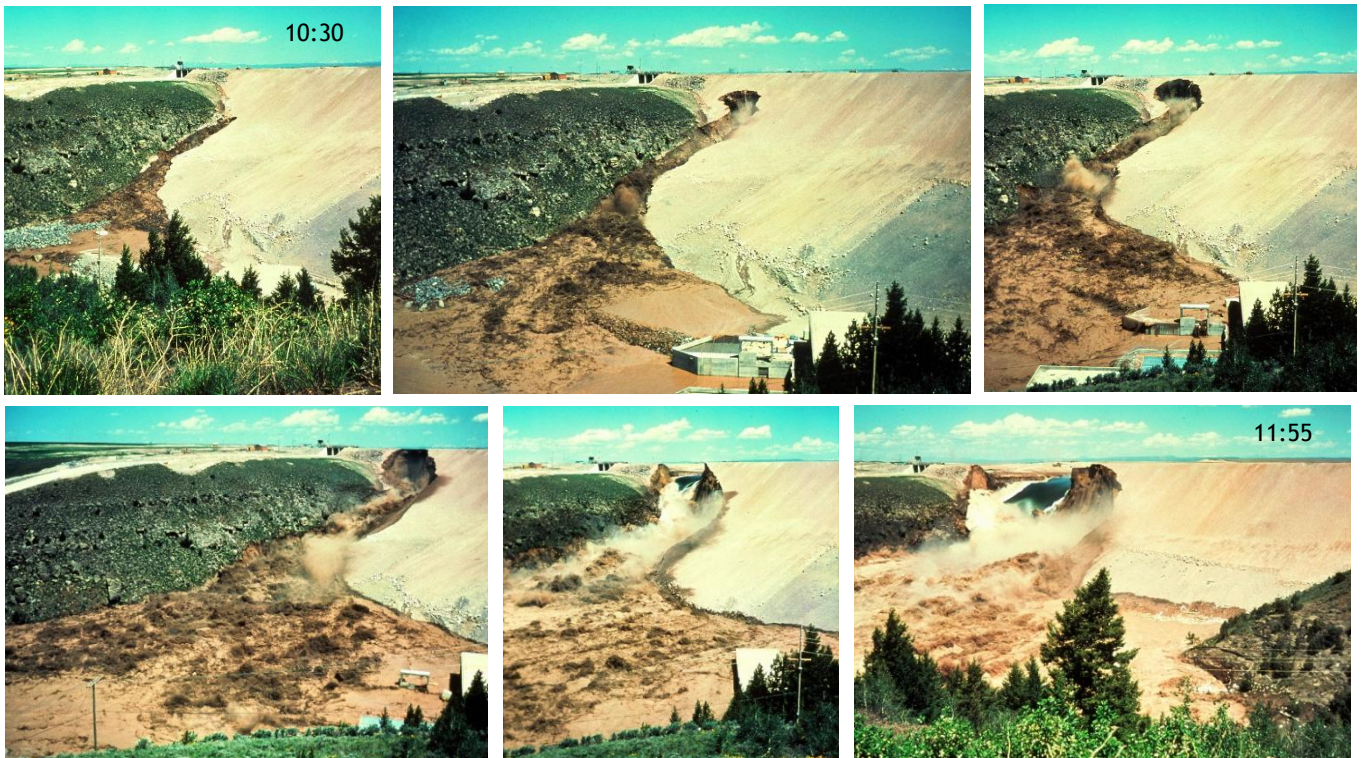
Figure 3 : Etapes de la rupture du barrage « Teton dam » : des premiers signes d'érosion visibles près du socle rocheux, jusqu'à la rupture et l'inondation, via l'apparition de l'écoulement boueux et l'élargissement de la brèche. Images Mrs. Eunice Olson [4]
