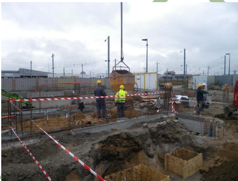
Photo 2 – porteur horizontal de type « Longrine »
