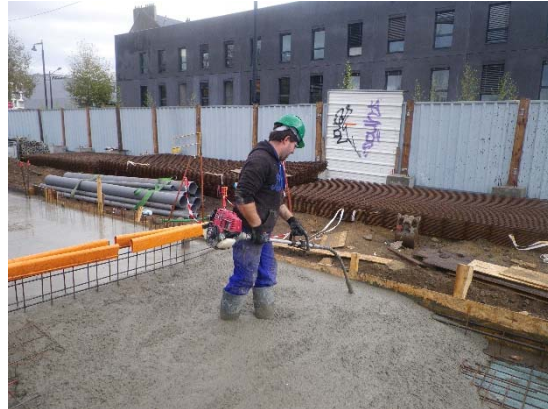
2 - Vibration du béton
