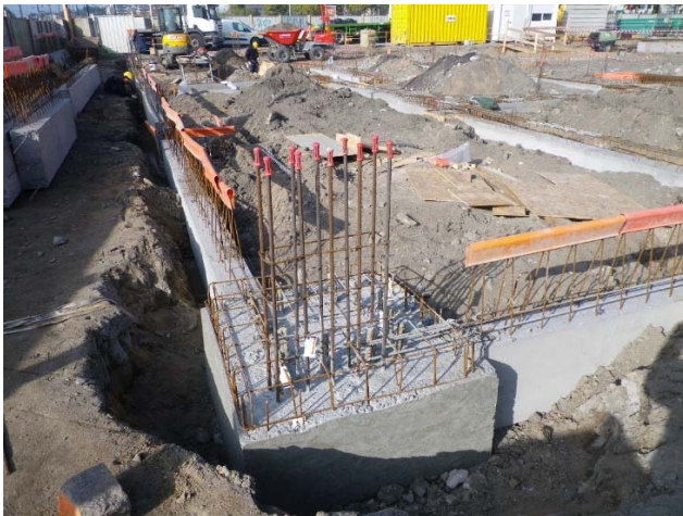
Photo 1 – porteur horizontal de type « Talon poutre voile »
