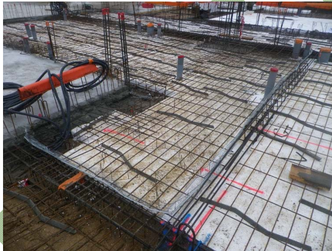
Photo 3 : Limite séparative entre deux zones de plancher.
