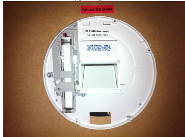
Détail bouche Hygroréglable Salle de Bains
