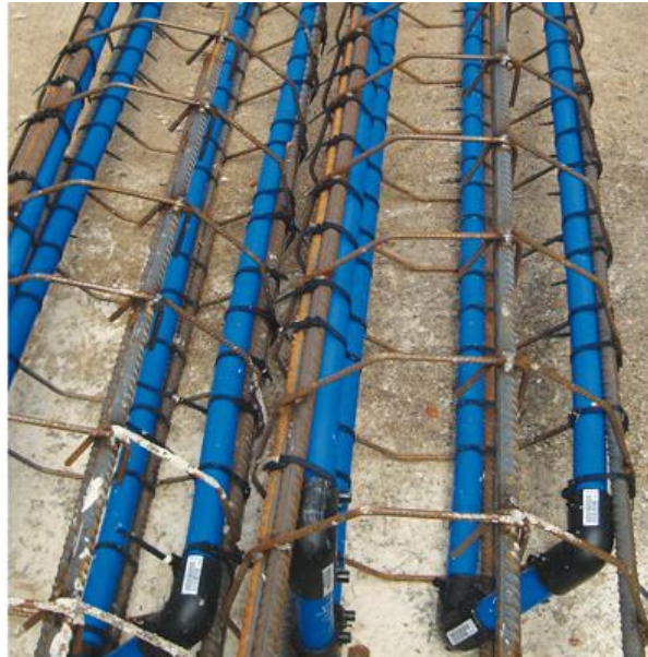
Figure 2 : Ferrailage et circuit d'eau d'un pieu géothermique
