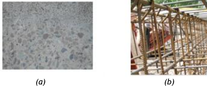
(a) (b) Figure 6 : Les constituants d'un béton armé : (a) le béton seul (qui est lui-même un multi-matériau), (b) les armatures métalliques.
