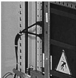
■ Déconnecter les deux prises à l'arrière de l'onduleur (alimentation et utilisation) et les connecter ensemble ; l'onduleur est alors consigné.
