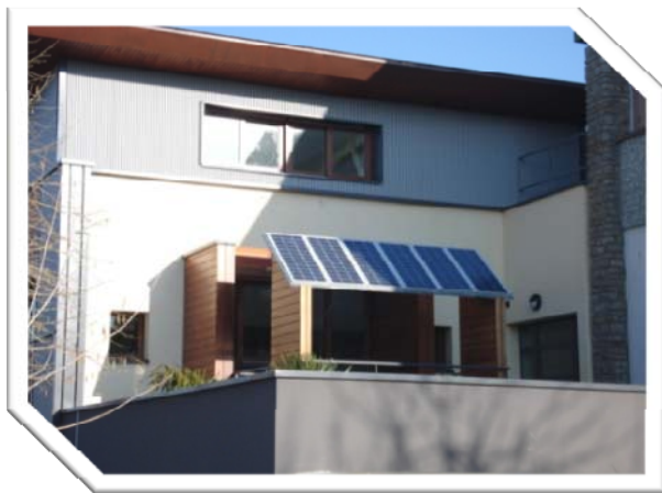
Panneaux solaires sur terrasse
