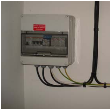
Coffret réseau ondulé ou réseau EDF
