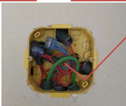
Etanchéité entre la boîte de réserve avec gaine électrique.
