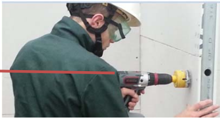
Mise en place des boîtes de réserve dans le volume hors habitable.
