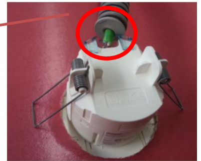
Etanchéité entre le câble bus du capteur de présence gaine électrique.
