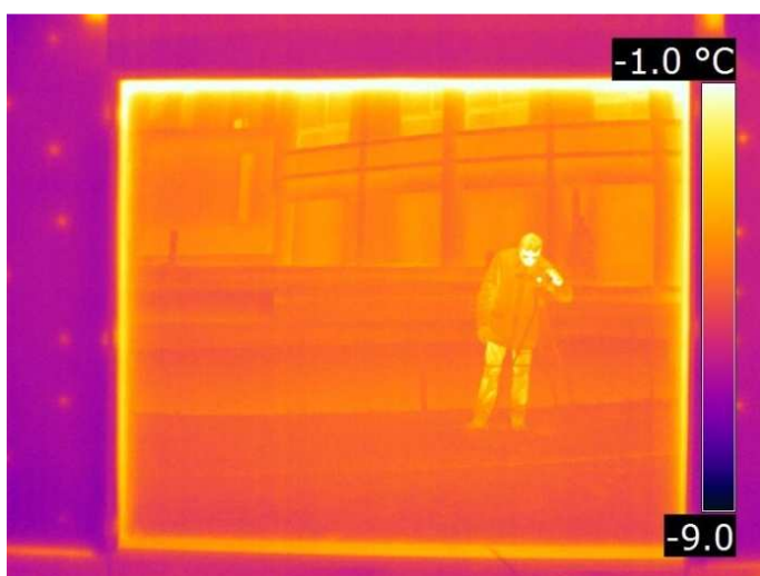
Figure 13 : Thermogramme de la baie vitrée
