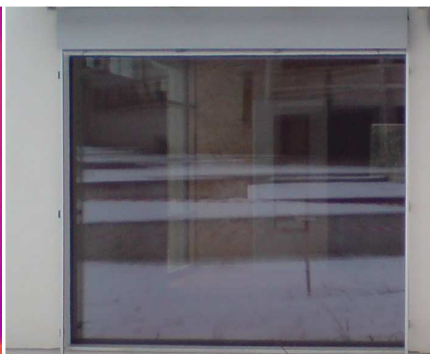
Figure 14 : Photo dans le visible de la baie vitrée
