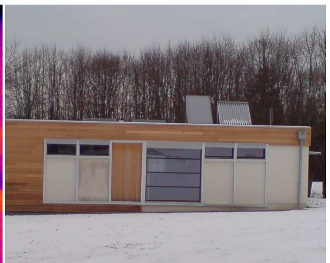
Figure 12 : Photo de la façade Sud de Pass_I*lab
