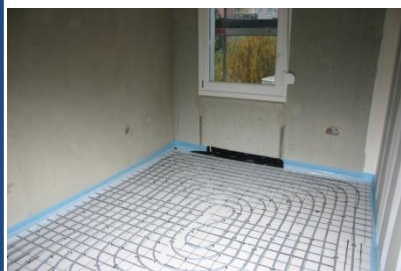
Figure 9, plancher chauffant avant la pose de la chape
