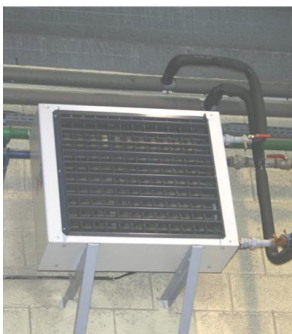
Figure 7, aérotherme
