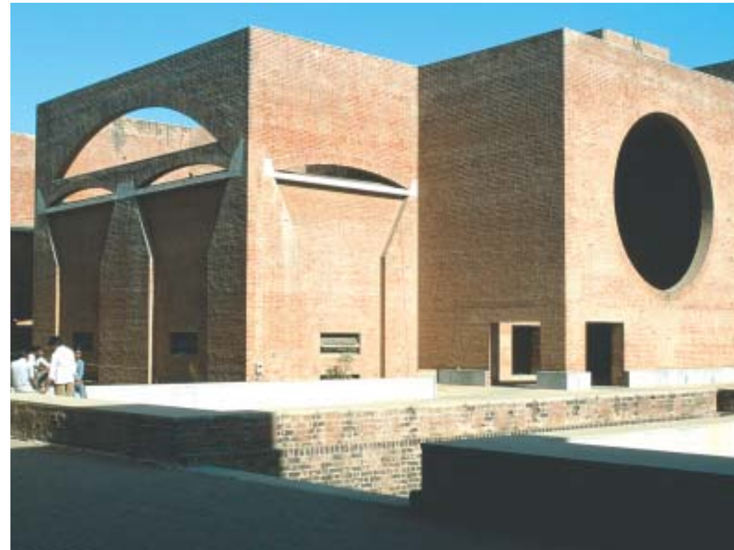
Les éléments structuraux, des arcs de briques et des tirants en béton, forment la base du principe de composition. Institut indien de management à Ahmedabad (Inde), Louis Khan.
