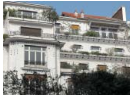
L'ornementation en céramique souligne la composition de la façade à gradins. Immeuble de logements à Paris, Henri Sauvage.
