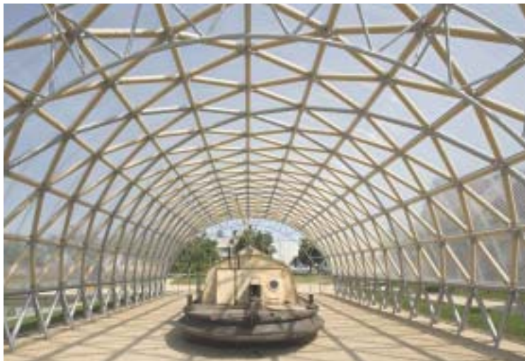
Structure associant métal, polycarbonate et tubes de carton recyclé. Halle du bateau Toueur à Pouilly-en-Auxois (21), Shigeru Ban.
