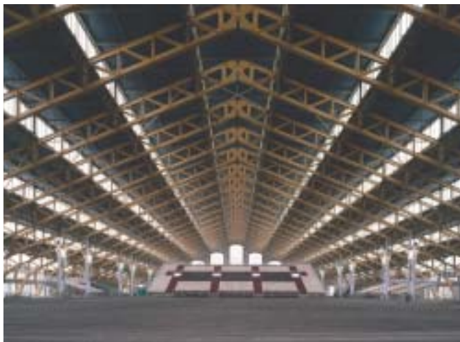
Grande charpente métallique à rotules. Halle Tony Garnier (1928) à Lyon (69). Rénovation par Reichen et Robert (1989).
