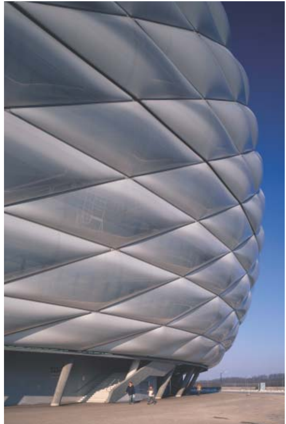
Une enveloppe faite de coussins d'air sous pression en polymère ETFE. Stade Allianz Arena à Munich, Herzog & de Meuron.
