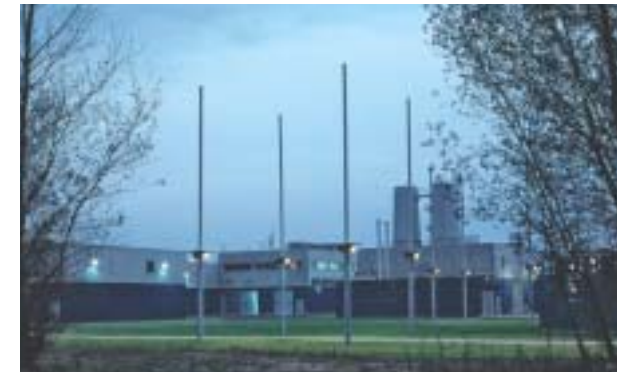
Des équipements techniques au service de la ville. Usine de traitement des eaux à Bègles (33), Jean de Giacinto.
