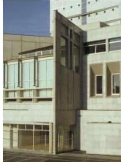
Le rythme et la forme des percements répondent à la singularité des espaces intérieurs. Archives de Paris, Henri Gaudin.
