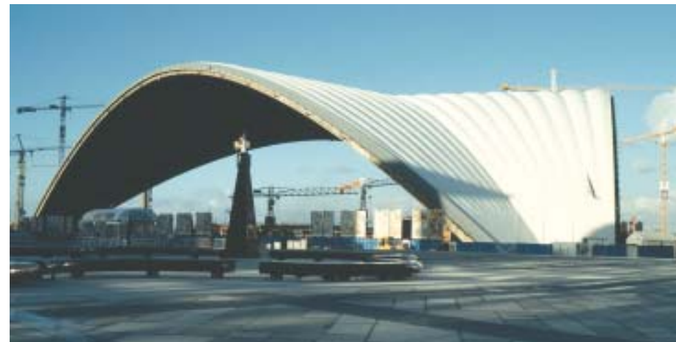
La coque en béton du CNIT lors de sa rénovation. CNIT, Paris-La Défense, Bernard Zehruss.
