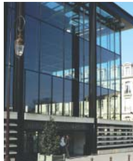
La structure porteuse en acier permet une transparence de l'enveloppe. Médiathèque à Reims (51), Jean-Paul Viguier.
