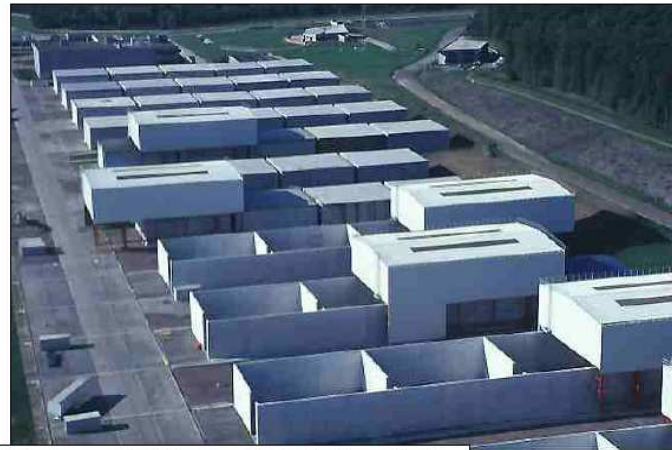
Lignes d'ouvrages à différents stades de l'exploitation
