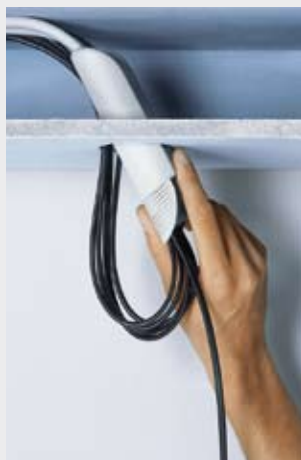
Le HTM® 150 une fois câblé sera inséré coté primaire en premier dans le faux plafond.
