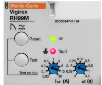
■ **Fonctions** : protection contre les défauts d'isolement par déclenchement électronique programmé, y compris avec les courants à composante continue (protection type « AC »  $\sim$  et « A »  $\curvearrowright$ )
