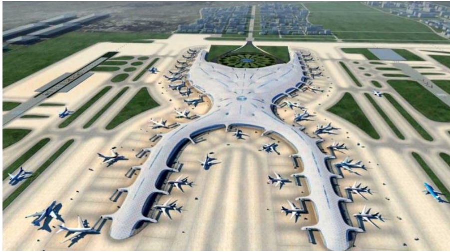
Figure 21 : Projet du Nouvel Aéroport International de Mexico, source ERSIGROUP
