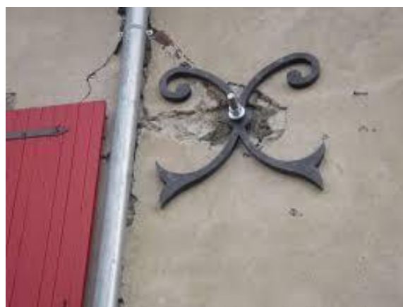
Figure 20 : Exemple de renforcement des constructions par des tirants visibles sur les façades par les croix de chaînage, sources [21,23]
