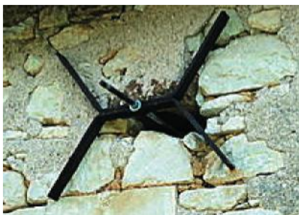
Figure 20 : Exemple de renforcement des constructions par des tirants visibles sur les façades par les croix de chaînage, sources [21,23]
