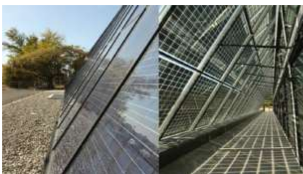
Figure 3: Façade semi-transparente photovoltaïque de 36kWc, orientée plein Sud du bâtiment ADREAM
