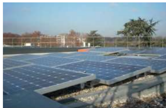
Figure 5: Toiture du bâtiment ADREAM située au dernier étage
