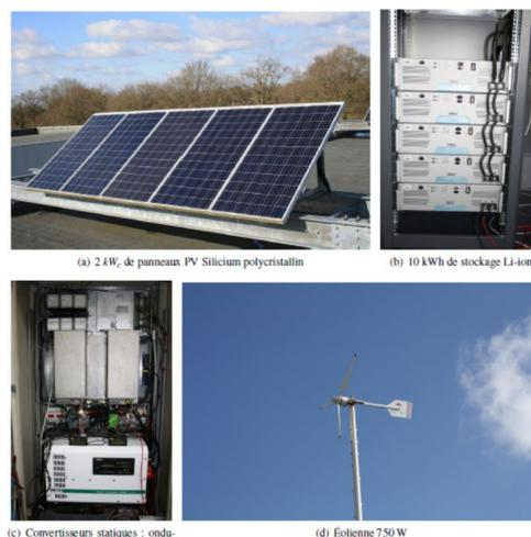
Figure 6. Photos des éléments du système implanté sur le site de l'ENS Rennes et du laboratoire SATIE – CNRS
