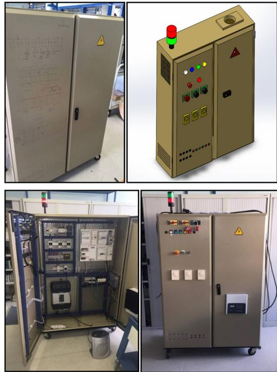
Fig. 4 (de gauche à droite et de bas en haut) : implantation du matériel, CAO mécanique sous SolidWorks(c), vue intérieure en fin de projet, vue extérieure en fin de projet.
