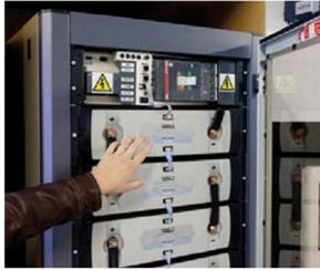
Assemblage de modules Batterie Lithium-ion
