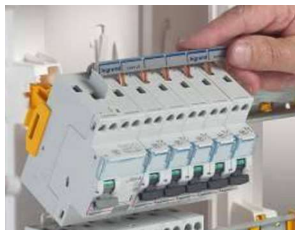
Installation des peignes
