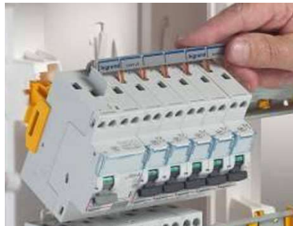
Installation des peignes
