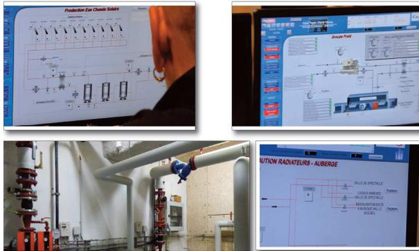
**Figure 2 : vue des écrans d'exploitation (GTB CVC ECS ...) et d'une partie de l'installation thermique de la halle (visite technique TP Line du 22/11/18)**
