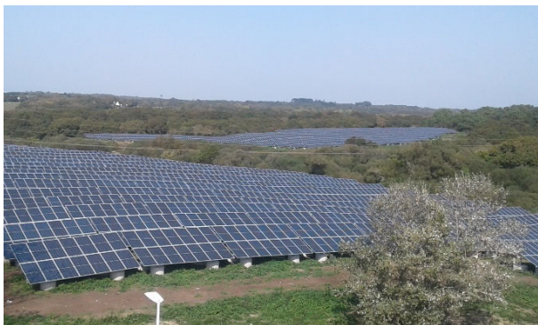
Figure 23 : vue de la centrale PV au sol installée sur l'ancienne décharge de la ZA de Kerdanvez, Crozon.
