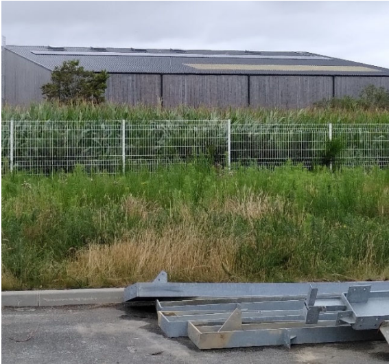
Figure 12 : bâtiment de tri des déchets bois et vue sur la rangée de modules PV en toiture
