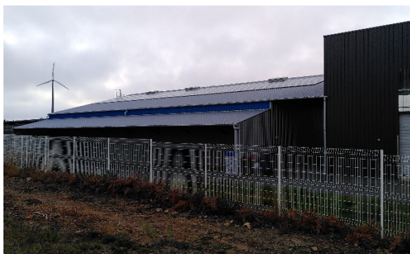
Figure 8 : éolienne (et son onduleur en pied de mât) et centrale PV sur le toit du bâtiment garage-atelier.
