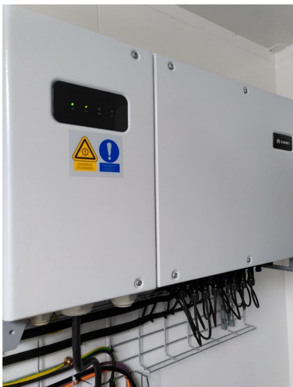
Figure 9 : onduleur PV HUAWEI modèle « Sun2000 36KTL » (8 chaînes PV possibles avec 4 entrées MPPT)
