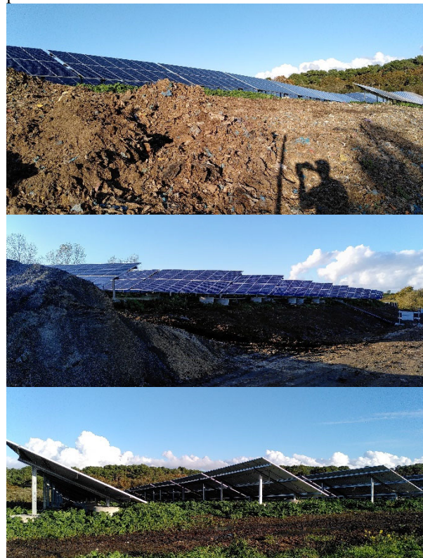
Figure 25 : vues des modules montés sur châssis lors de la phase de construction de la centrale PV
