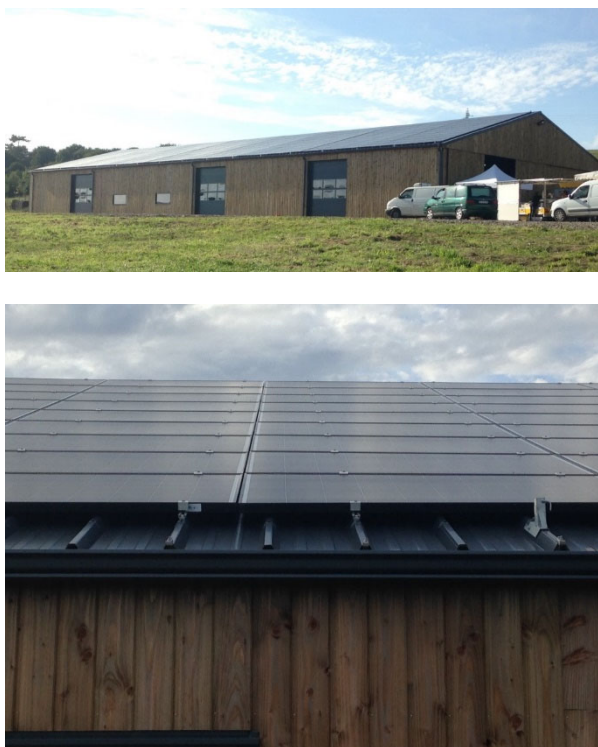
Figure 5 : les toitures des deux bâtiments (atelier et point de vente/stock/dégustation) de la cidrerie de Rozavern 6 sont équipées de modules en surimposition.
