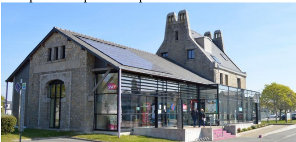
Figure 2 : vue de la centrale PV en toiture de l'ancienne gare, aujourd'hui gare routière et office de tourisme
