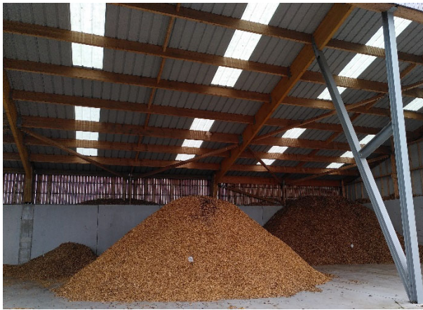
Figure 1 : vue de la plateforme couverte de stockage et séchage des plaquettes de bois (ZA de Kerdanvez)
