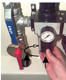
Appliquer une pression montante, tout en dévissant la cuve
