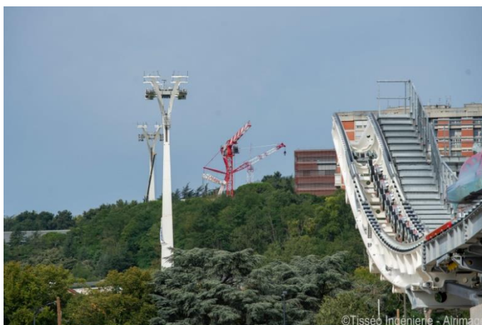
Construction des 5 pylônes
