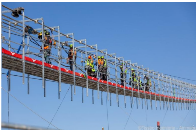
Réalisation de l'épissure sur le câble tracteur
