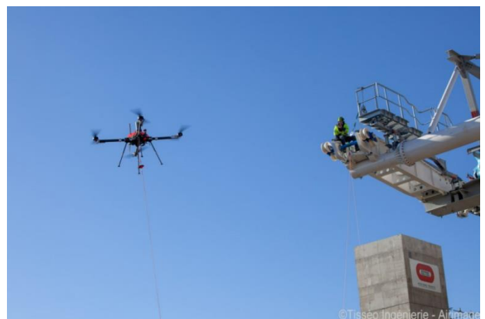
Déroulage des câbles par drone
