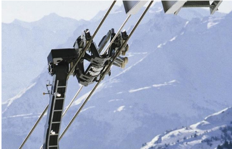
Figure 9 : Chiot et câbles d'un téléphérique 3S, source [1]
