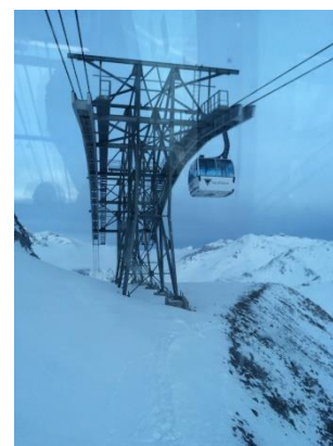
Figure 34 : TPH 3S de l'Olympique, Val d'Isère, Savoie, source [6]
