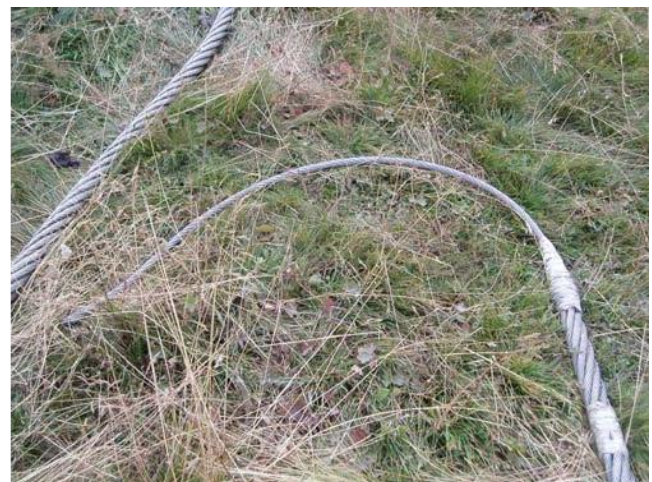
Figure 39 : Filin installé sur la ligne et câble définitif accroché à l'extrémité du filin, source [1]
