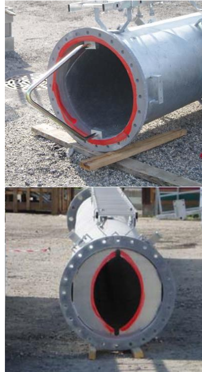
Figure 38 : Système permettant de faciliter l'emboîtement des pylônes, source [1]
