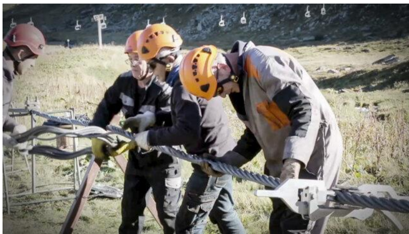
Figure 41 : Réalisation l'une épissure de câble de remontée mécanique, source [14]
