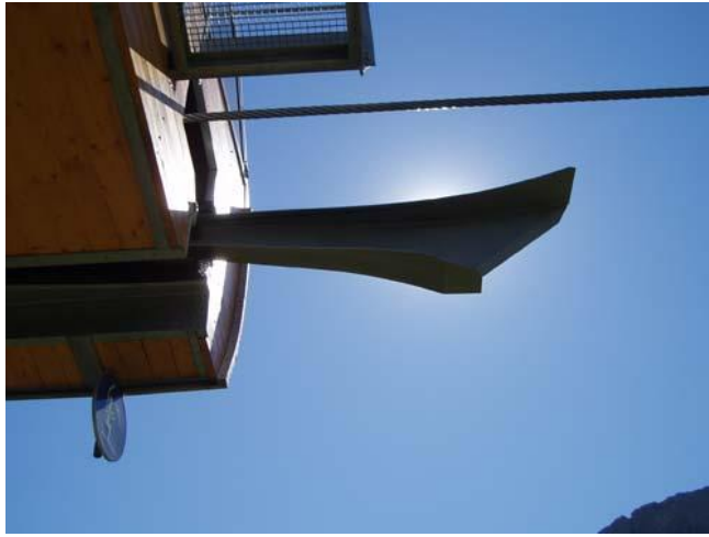
Figure 19 : Trompette d'entrée de gare Doppelmayr, source [1]
