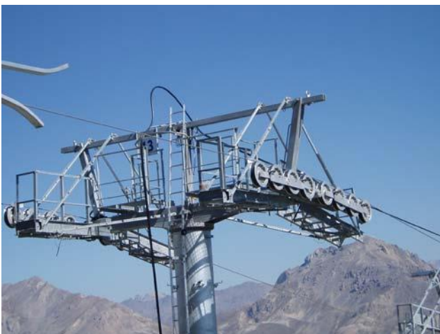
Figure 39 : Filin installé sur la ligne et câble définitif accroché à l'extrémité du filin, source [1]
