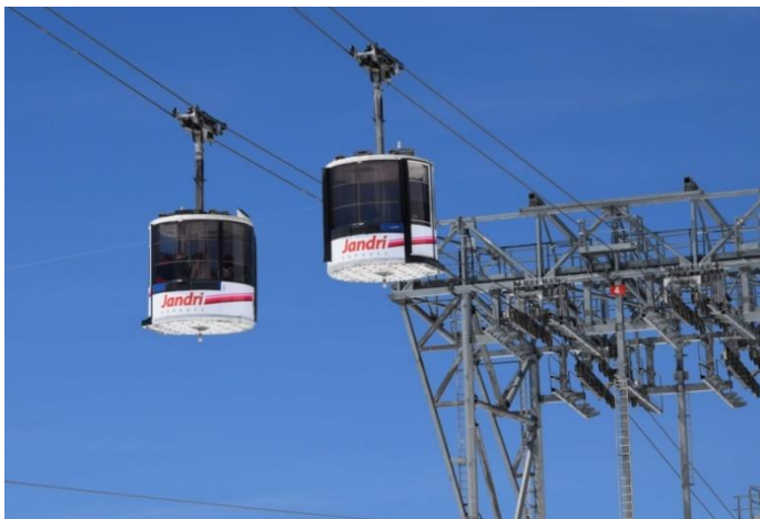
Figure 1 : Le Jandri Express des Deux Alpes, double monocâble à attaches débrayables qui, en deux tronçons, permet de relier la station, 1800 m d'altitude, au pied du glacier situé à 3200 m, source [23]
