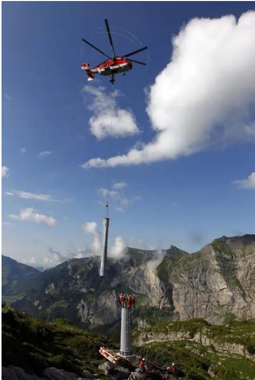
Figure 37 : Installation d'un pylône par hélicoptère, source [21]
