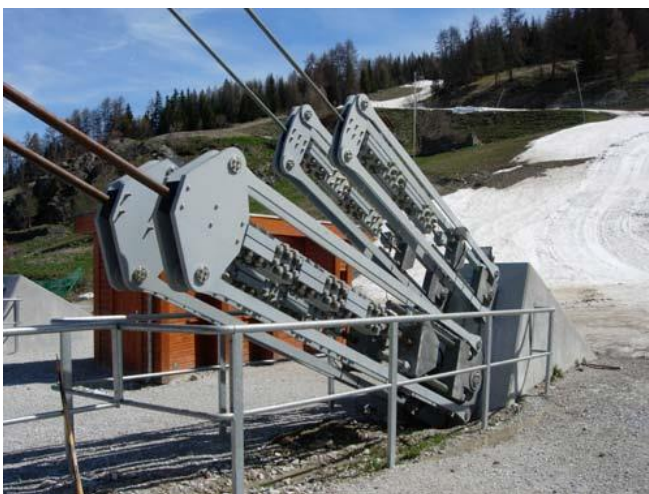
Figure 27 : Ancrage des câbles porteurs du Vanoise Express, Suisse, source [1]
