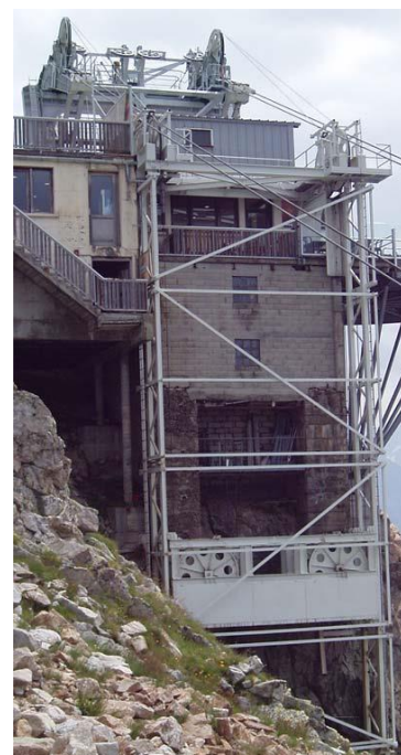
Figure 28 : Dispositif de tension des câbles tracteurs, TPH du Brévent, Chamonix, source [1]
