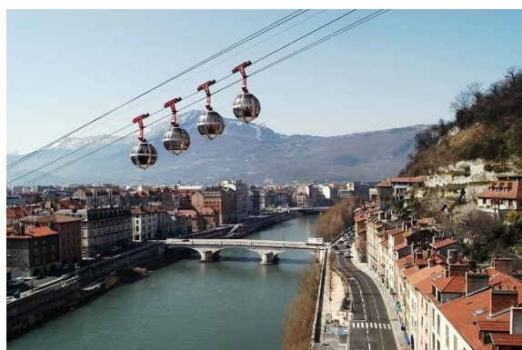
Figure 31 : TPH Pulsé, Grenoble, Isère, source [9]
