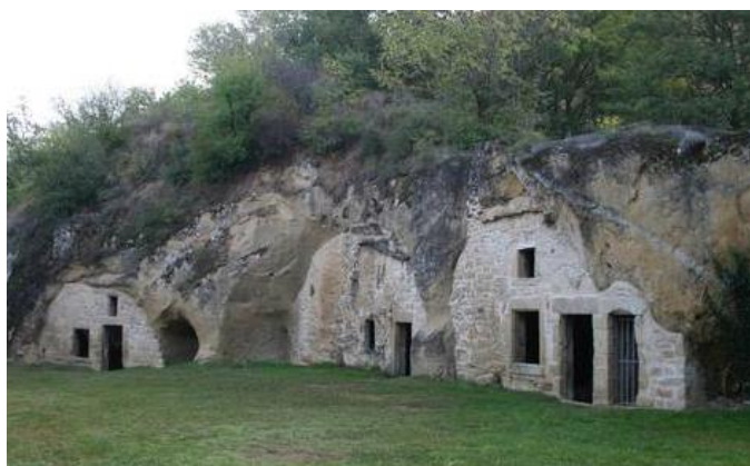
Figure 9 : Maison troglodyte à Châteauneuf-sur-Isère (Drôme)
