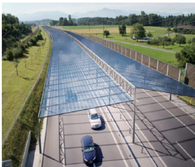
En Allemagne, l'idée de « L'Autobahn solaire » est prometteuse. Il ne s'agit pas d'utiliser la route (voir § 4.2) pour transformer une énergie mécanique en électricité mais d'utiliser des panneaux solaires implantés au-dessus de la chaussée.
