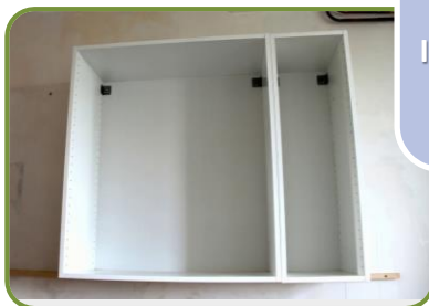
Projet 2 - Pose d'un caisson de cuisine
