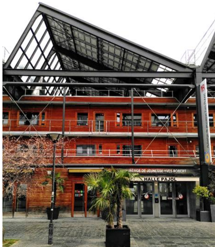
Figure 4 : Vue de l'entrée de l'auberge de jeunesse Yves Robert (330 lits, bar et restaurant) avec les modules positionnés sur la partie orientée sud d'un « shed » de la charpente conservée (07/01/2020).
