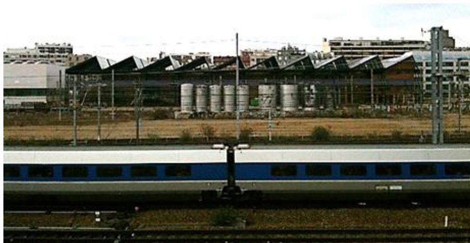
Figure 3 : Vue de la halle Pajol depuis le jardin d'Eole (à l'est), de l'autre côté des voies de chemin de fer de la Gare de l'Est. Une rangée de panneaux solaires thermiques y est visible, sous la toiture en « sheds ».
