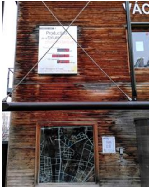
Figure 18 : Vue du panneau d'affichage didactique et d'information visible de l'esplanade, le 07/01/2020 à 13h, par temps froid et couvert (Pinstantanée=45kW / Production totale cumulée=3011539kWh / CO2 économisé=2108tonnes)
