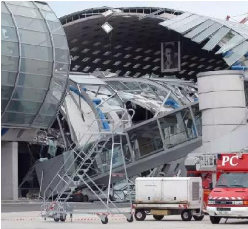
Figure 9 : Voûte effondrée, source [15]
