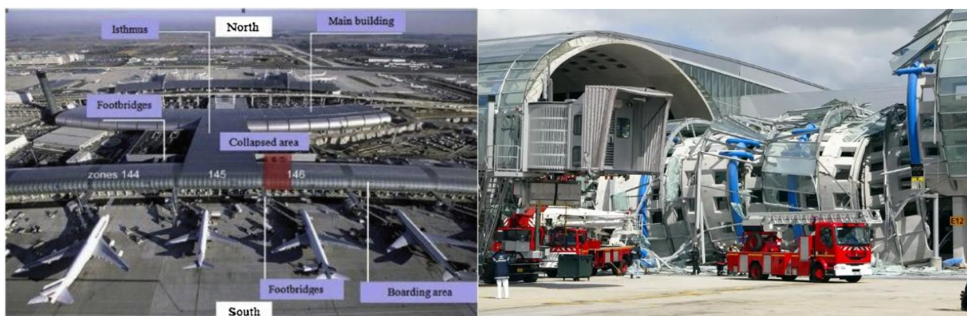
Figure 1 : Vue d'ensemble du terminal 2E et zone de l'effondrement, source [7][3]
