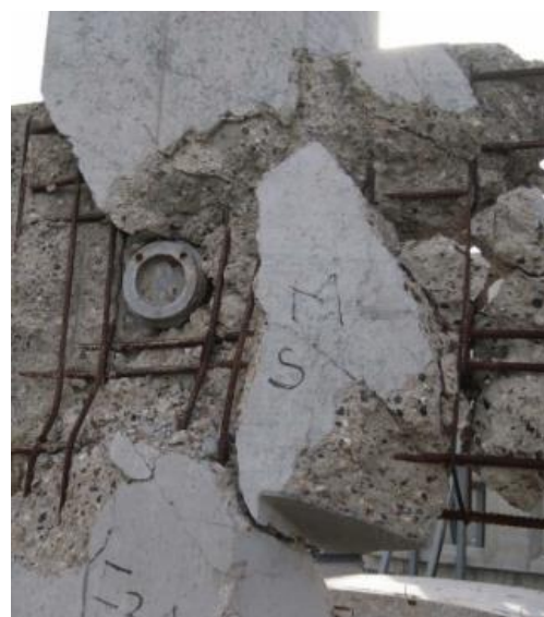
Figure 13 : Dislocation du béton autour des butons, source expertiseSetec
