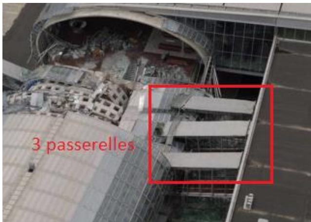
Figure 3 : Effondrement du toit dans la zone des 3 passerelles, et modélisation de la zone, sources [7] [8]
