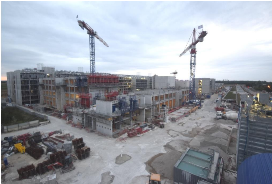
Figure 12 : Grues à montage par éléments (GME) à tirants (droite) et sans tirants (flat top), source chantier ENS Paris-Saclay 2018
