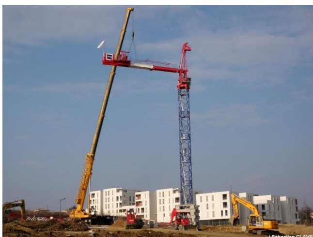
Figure 16 : Montage d'une GME à l'aide d'une grue mobile, source [17]
