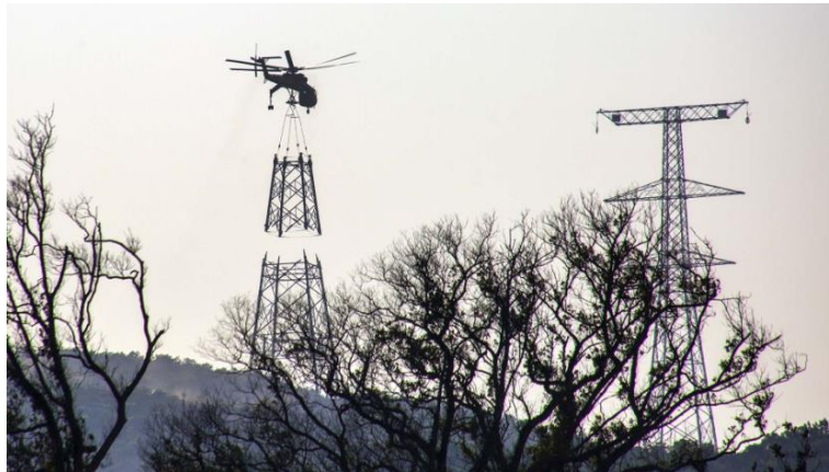
Figure 17 : Construction de pylônes électriques dans la province de Zhejiang (Chine) en octobre 2018, levage de charges de 9 tonnes par hélicoptère, source [18]
