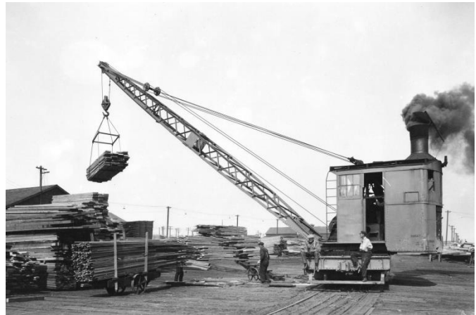
Figure 9 : Grues à vapeur sur rail, Summerlee Heritage Park et sur chenilles, sources [11] [12]
