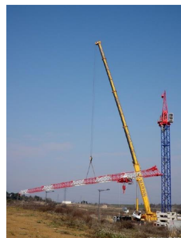
Figure 16 : Montage d'une GME à l'aide d'une grue mobile, source [17]
