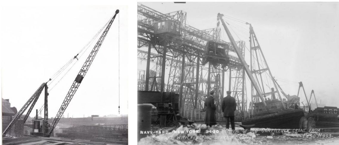
Figure 7 : Derricks à vapeur, Melbourne, et monté sur un navire, New-York 1920, source [9]
