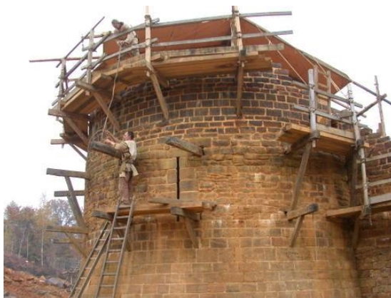
Figure 5 : Exemples d'échafaudages en bascule sur le chantier médiéval de Guédelon (Bourgogne), source [5]
