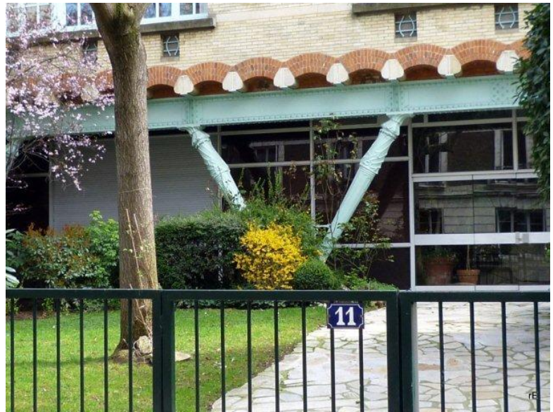
Figure 5 : Piliers de l'École du Sacré-Cœur, détail du style Art Nouveau et structure en V, source [5]
