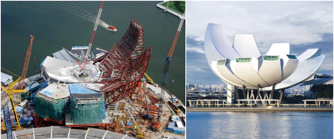
Figure 19 : ArtScience Museum en construction et terminé, sources [32] [33]
