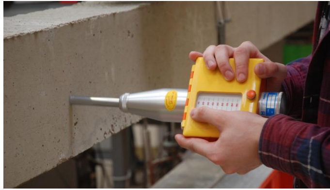
Figure 8 : Estimation de la résistance du béton à l'aide d'un scléromètre
