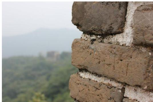
Figure 34 : Mortier de la muraille
