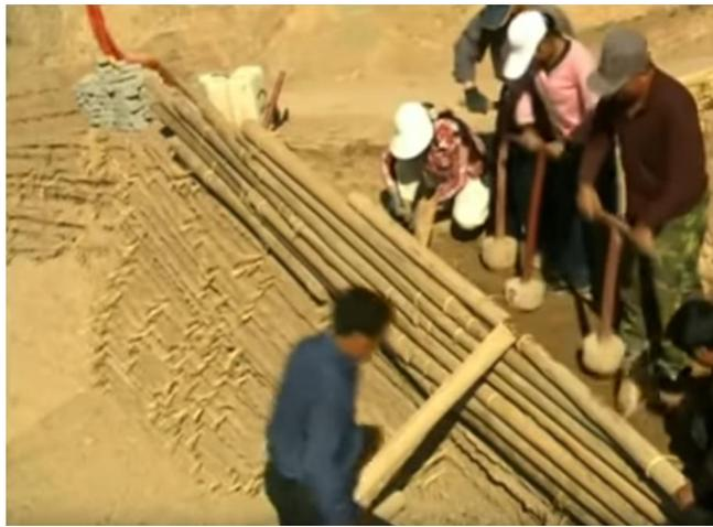
Figure 7 : Coffrage en rondin maintenu par les liens de paille torsadé pour le pisé, restauration d'un mur dans le désert de Gobi, source [8].
