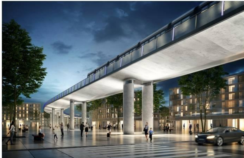
Figure 2 : Allure du futur viaduc de la ligne 18 sur le plateau de Saclay, source [5]
