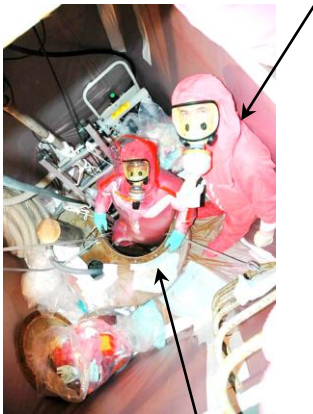
Accès par le trou d'homme en tenue ventilée
