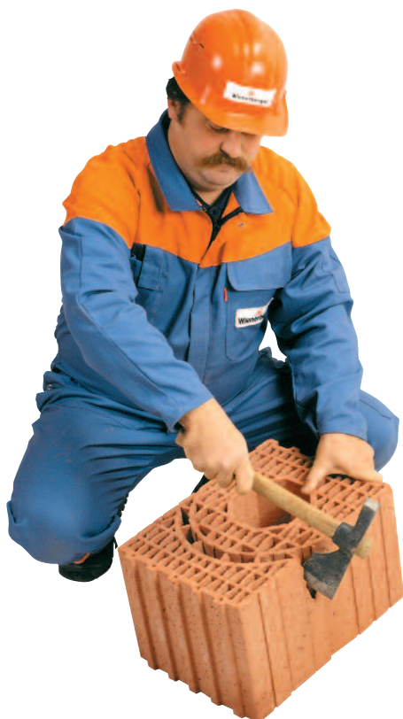
Séparation des éléments du poteau multi-angles.
