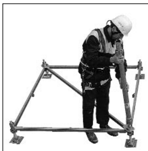
2 Mise en place des poteaux courants et verrouillage sur les vérins par quart de tour.
