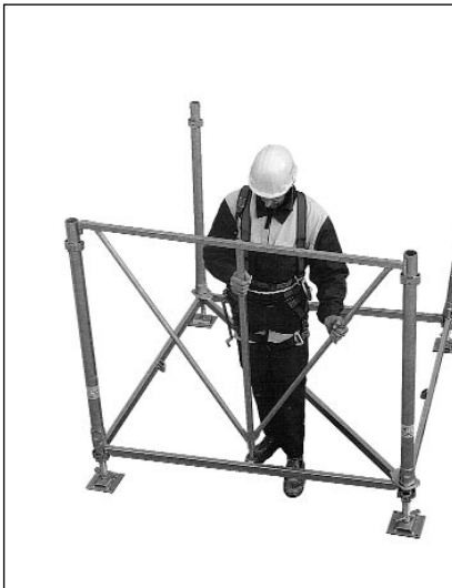
5 Pose de l'étage courant supérieur.
