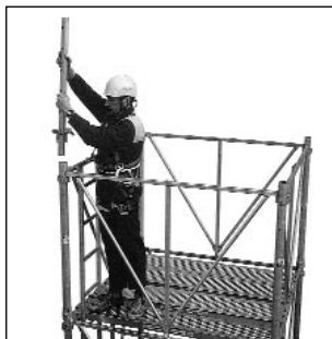
4 Pose, brochage et verrouillage des poteaux coulissants.
