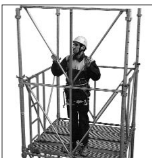
5 Pose et brochage des cadres coulissants.
