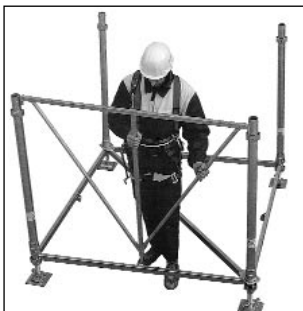
3 Pose des cadres courants sur les poteaux courants et les traverses de base.
