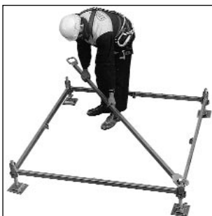
1 Pose des vérins de pied, des traverses de base, de la diagonale et mise à niveau.
