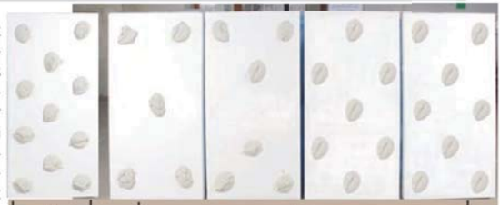
4. Pose collée 11 plots (16/m 2 ) 5. Pose calée / chevillée 5 plots (6,9/m 2 ) 6 plots (8,3/m 2 ) 7 plots (9,7/m 2 ) 8 plots (11,1/m 2 )
