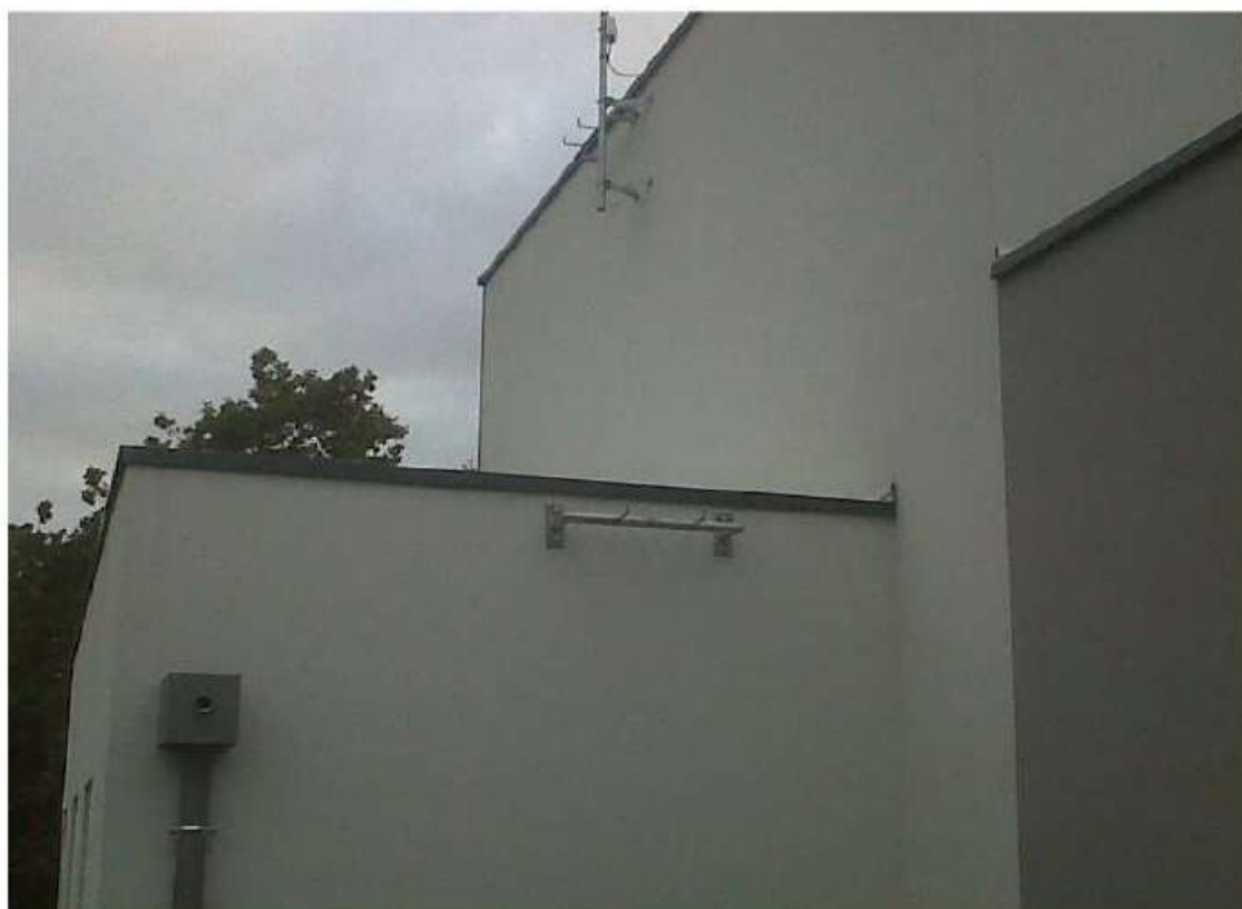
MODELE DE BARRE D'ECHELLE A CROCHETS (pour utilisation d'une échelle standard)
