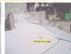
3/ Les ancrages d'arrimage sont posés pour sécuriser le pont de l'ossature bois et pour ancrer les poteaux de bois.
