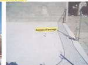
2/ Les ancrages d'arrimage sont posés par le Gros Oeuvre. Ils sont posés dans les dalles ou les poteaux. Ils sont posés dans les dalles ou les poteaux.
