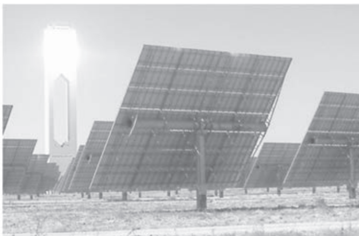
Figure N°1 : vue du champ d'héliostats et de la tour de la centrale PS10
