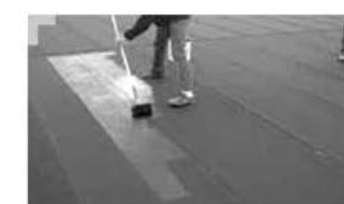
Application du primaire, Soprasolar® Prim. Traçage +5 cm empreinte cellules.
