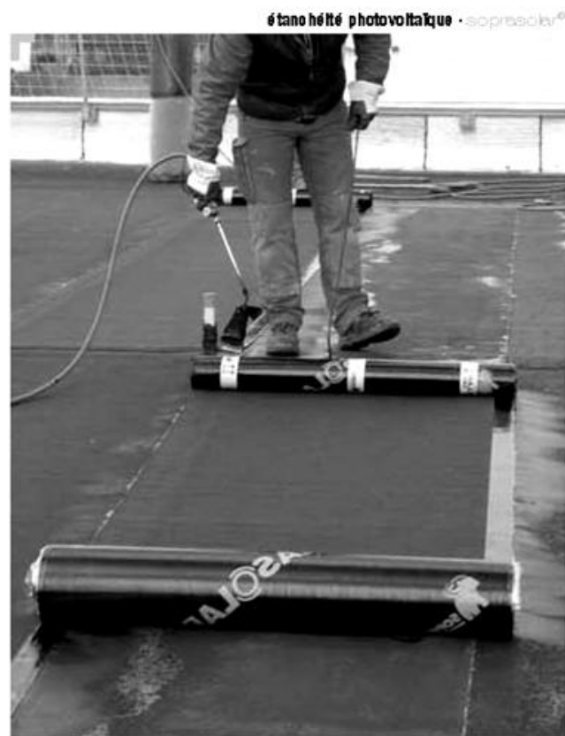
Application de Soprasolar® Cap, 2 ème couche silicée auto-protégée
