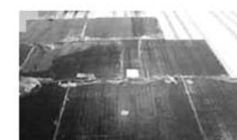
Pose de l'isolant de classe C fixé mécaniquement.
