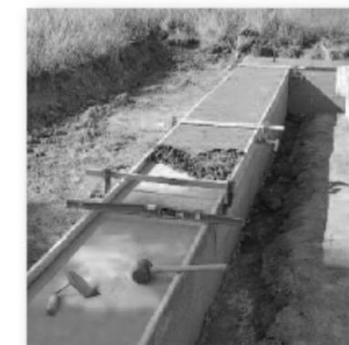
Arasement du mortier sur longrines. Retirer les règles avant pose du 1<sup>er</sup> rang de briques.
