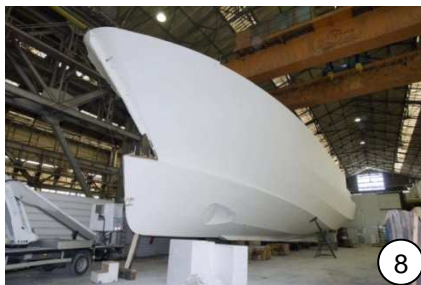
Équipement et renfort des demi-coques (4)
